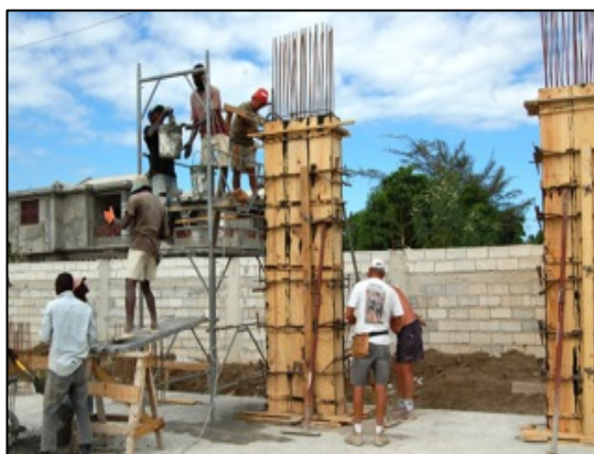
Lavori di costruzione del centro comunitario
